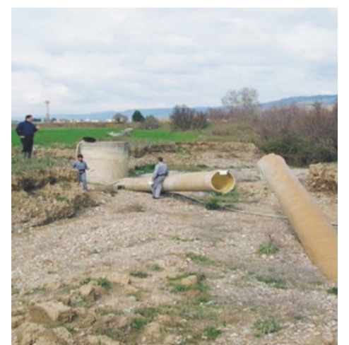
FOGNA La condotta risultata spezzata
